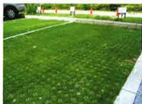
○全体強化プラスチックマット型 利用が少ない駐車場向け。
