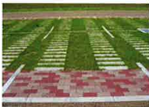
○車輪部補強型 利用が少なめから普通程度の駐車場向け。
